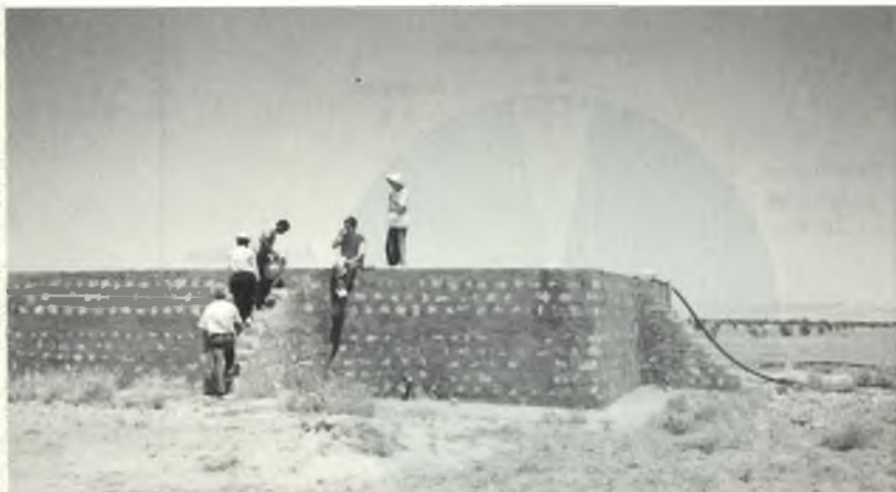
Bassin de stockage de l'eau.
