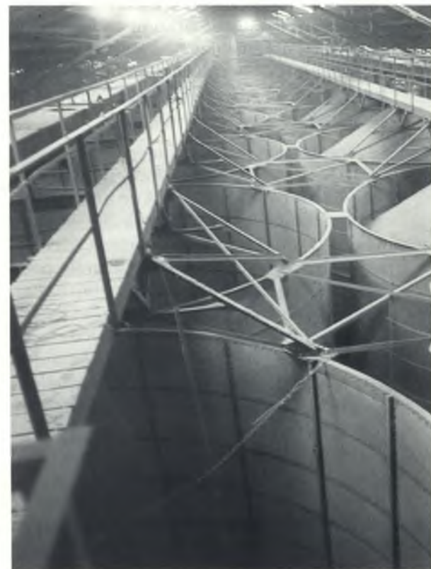
Silos en rizerie. Cliché M. Grillard
