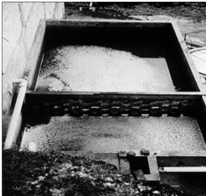
Photo 1. Le bassin de stockage ( V = 36 \text{ m}^3 ). El tanque de almacenamiento ( V = 36 \text{ m}^3 ).
