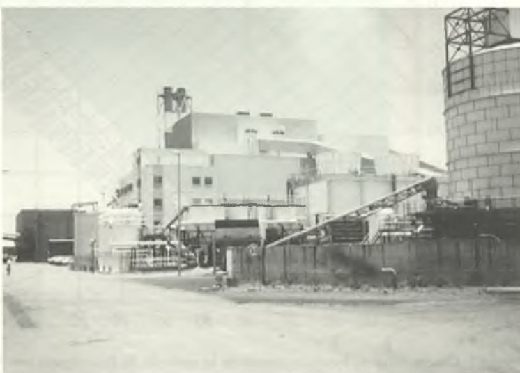
Vue de la centrale de Bois-Rouge. Cliché B. Robert
