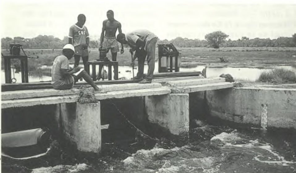
Le barrage anti-sel de Djilakoun dans le bas-fond de Djiguinoum. Les portes sont levées pour lâcher les eaux salées en début de saison des pluies.
