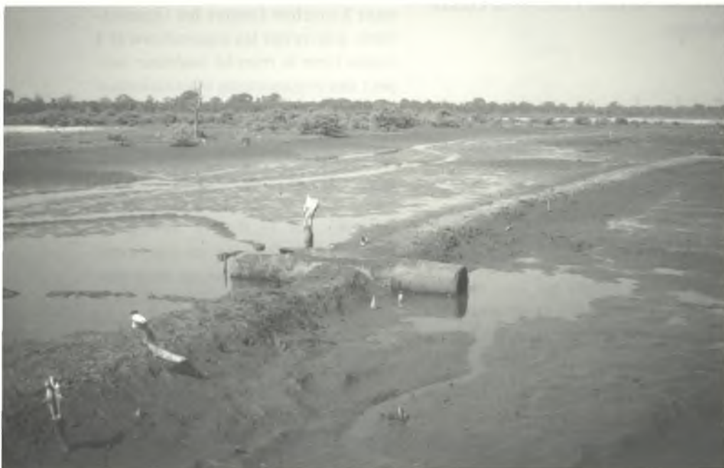
Système traditionnel de vidange des eaux de submersion d'une ancienne rizière abandonnée à cause de la sursalinisation des eaux marines et de nappe (tronc de ronier évidé).
