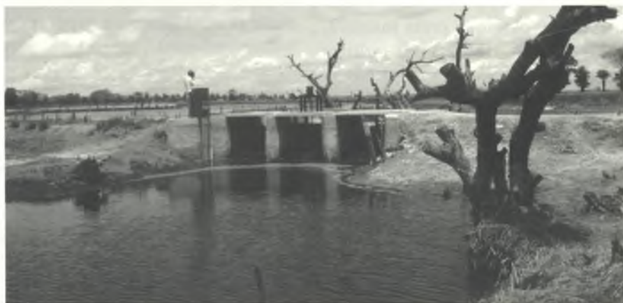
Le bas-fond inondé de Djiguinoum, au début de la saison des pluies, en amont du barrage anti-sel de Djilakoun. La retenue est en cours de remplissage avec les eaux pluviales lessivant et drainant les sols salés.
