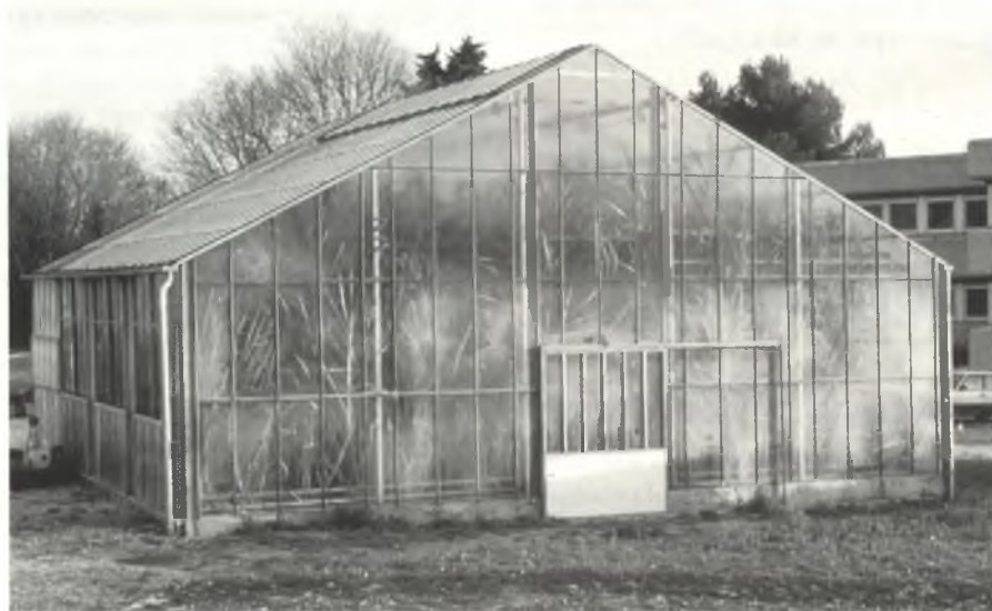
La serre de quarantaine canne à sucre de deuxième cycle du Cirad à Montpellier. En arrière-plan, le bâtiment abritant le laboratoire de phytopathologie.
