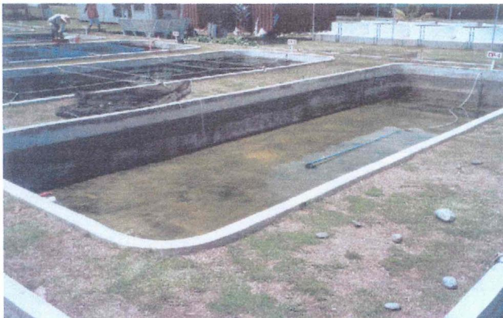
**Photo 13** : L'un des 15 bassins cimentés situés en extérieur. Ce bassin a une contenance de 25 m<sup>3</sup> et peut accueillir jusqu'à 4 hapas de 4 m<sup>3</sup> chacun. Ces structures sont nettoyées tous les mois.
