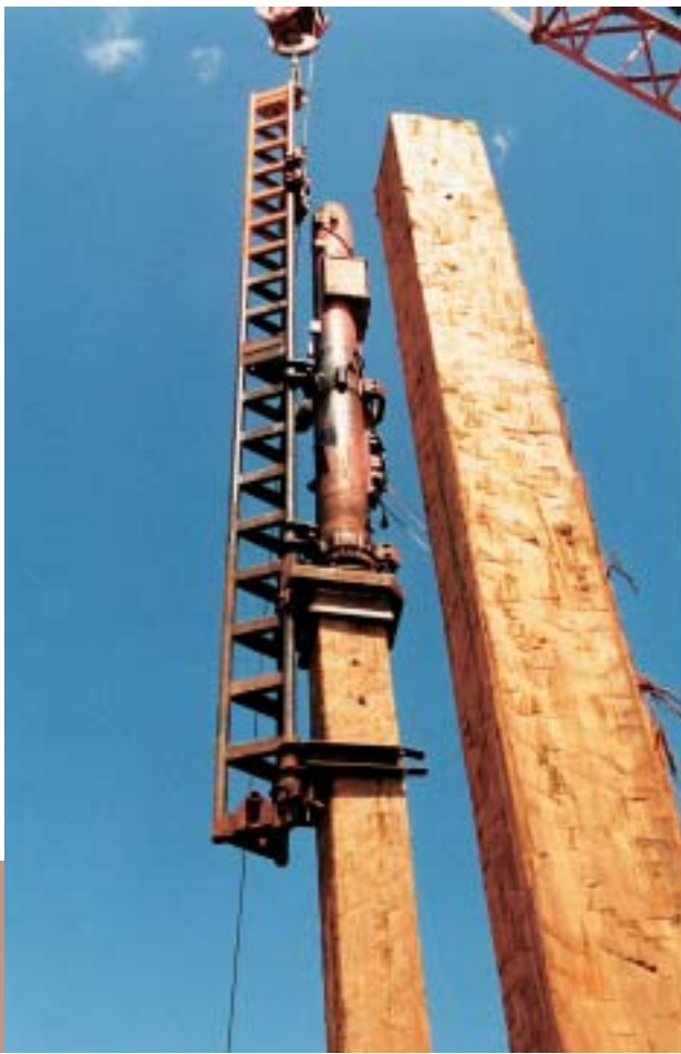
Un pieu équarri (à gauche) soumis à la machine de battage pour la mise en place en milieu portuaire. Photo P. Langbour.
