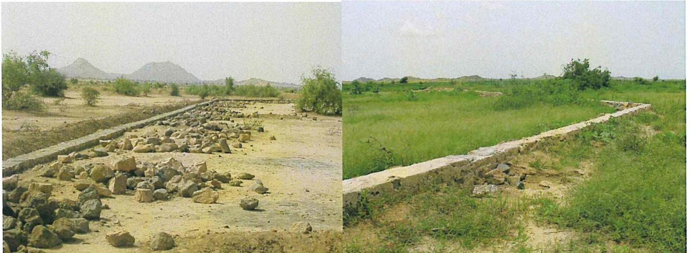
Figure 21 : Ailes d'un seuil d'épandage dans le BV Ouadi Chaou, avant et après la saison pluvieuse.
