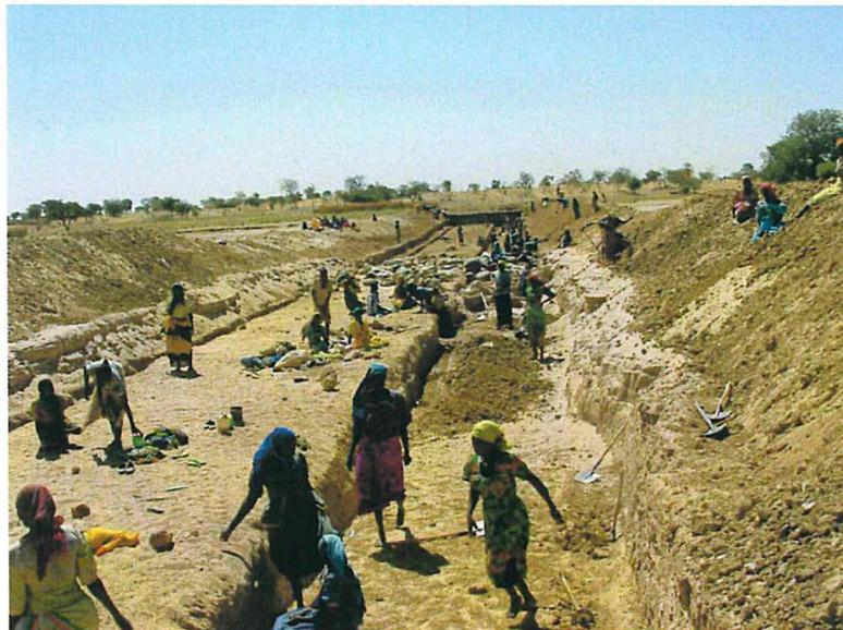
Figure 27 : Fouilles pour la construction d'un seuil d'épandage entre Farchana et Hadjer Hadid, mars 2006.
