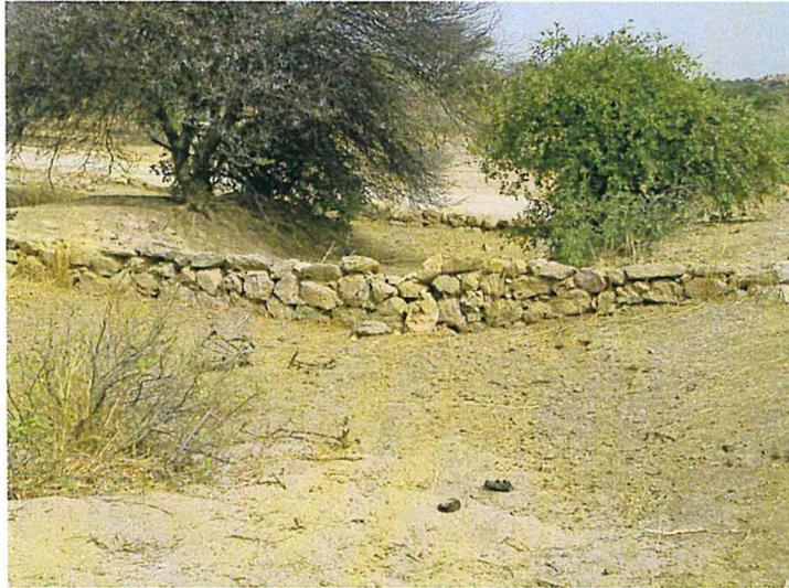
Figure 18 : Diguettes construites dans une rigole.
