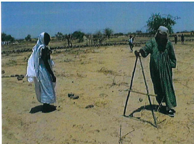
Figure 13 : Utilisation du niveau « A » pour tracer la courbe d'eau.
