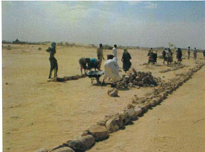
Figure 19 : Construction de diguettes dans le bassin versant de Sélélé, mars 2001.
