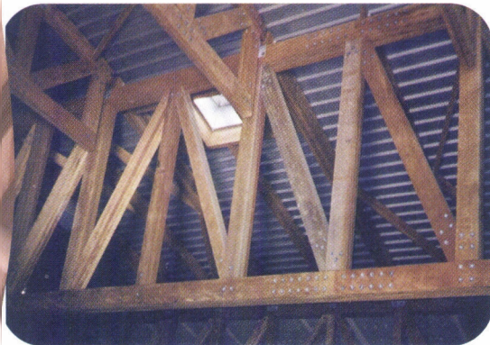
La ferme principale de l'auditorium de l'ENCRE. Portée 24 mètres, hauteur 3 mètres.
