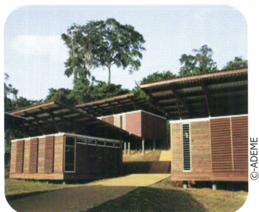
Les grands débords de toiture protègent les façades et limitent l'apport thermique à l'intérieur de la construction - Collège de Papaïchton
