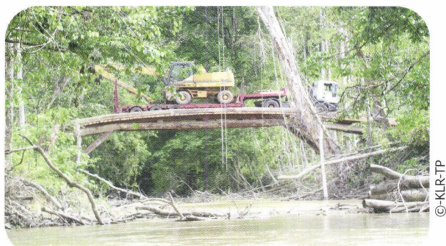
Le pont de la crique Serpent, sur la nouvelle route d'Apatou, a une portée de 24 mètres.
