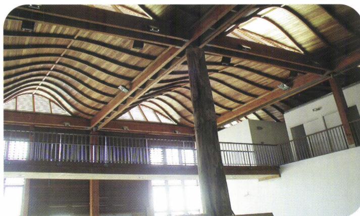
La médiathèque de Kourou est également conçue pour utiliser les vents dominants pour la ventilation des locaux, grâce aux alvéoles dans la toiture.
