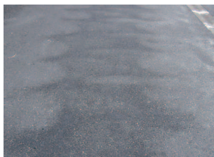
Badigeonnage avec une seule buse : traitement peu efficace.
