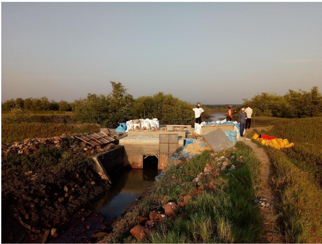
Ouvrage permettant une gestion contrôlée des entrées d'eau de mer et drainage des eaux douces dans les périmètres rizicoles de mangrove
