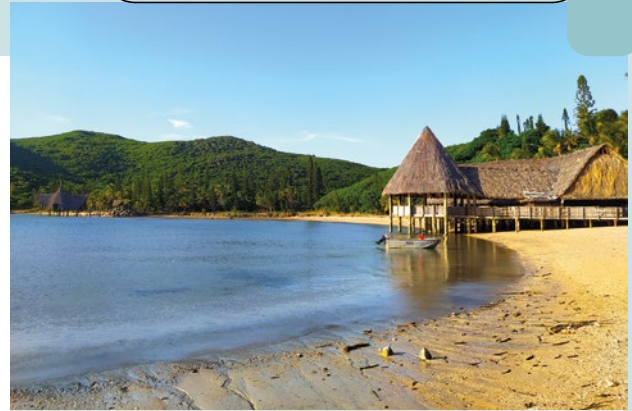
Photo 1. Ponton abrité, réalisé avec des poteaux en pin radiata ( Pinus insignis ) traités au CCA ( Chromated Copper Arsenate ), à Nouméa, Nouvelle Calédonie, France. Photo K. Candelier.
