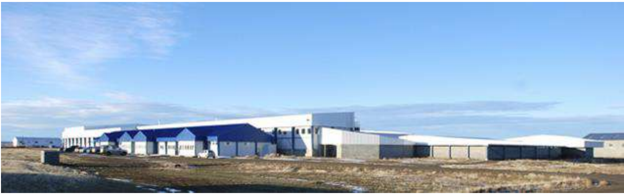
Figura 7.7. Fotografía del Frigorífico Estancias de Patagonia, Río Gallegos. Recuperado de http://estanciasdepatagonia.com/espanol [consultado 04/07/1018].
