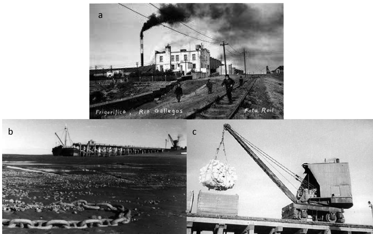
Figura 7.5. Fotografías de la infraestructura de apoyo a la ganadería, en Río Gallegos tomadas en primera segunda mitad de siglo XX. A) Frigorífico Swift, b) Muelle Swift, c) Grúa a vapor cagando en Muelle Swift. Fotografías tomadas por Walter Roil. Disponibles en Archivo Roil.
