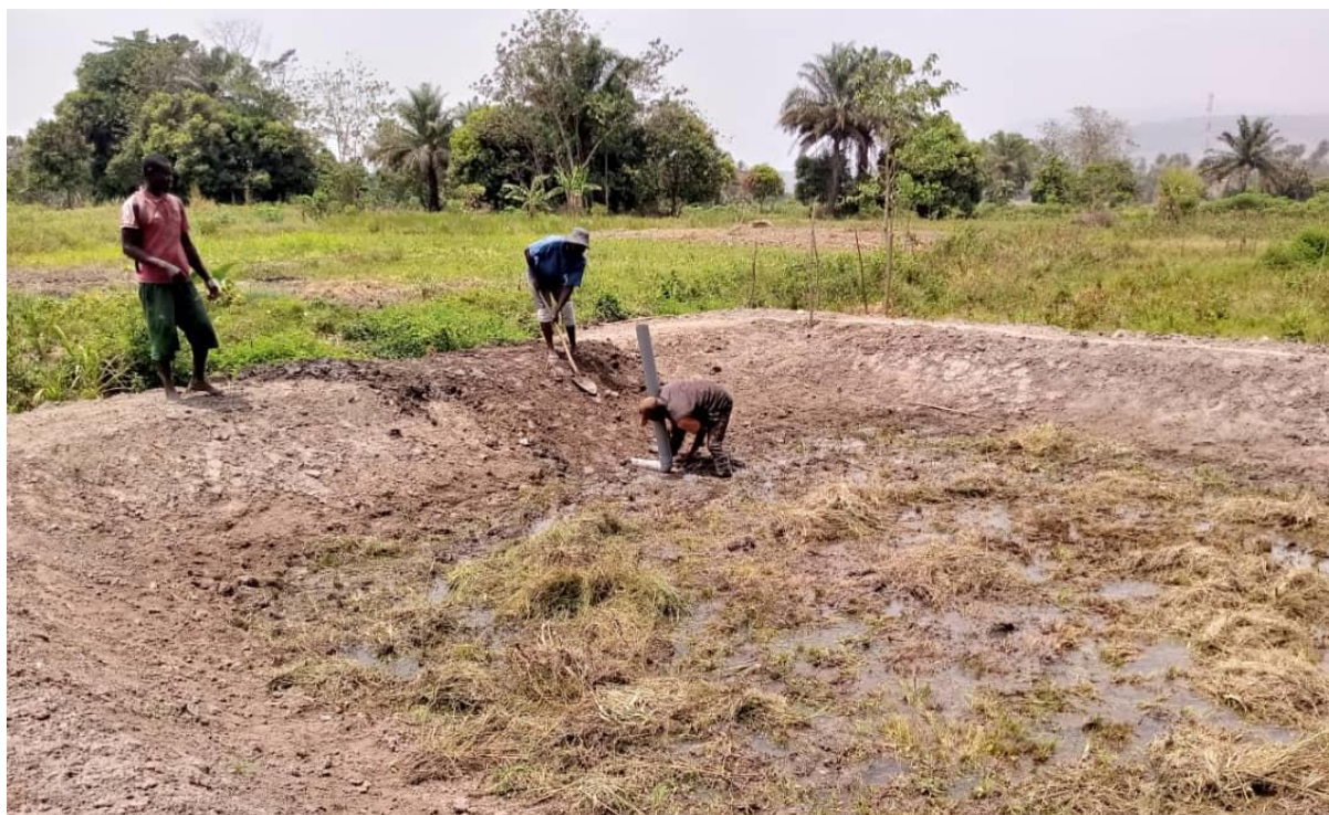
Construction de l'étang de service (1 are) chez Fodé Abas à Gbériakhory, pose du système de vidange avec tuyau PVC.
