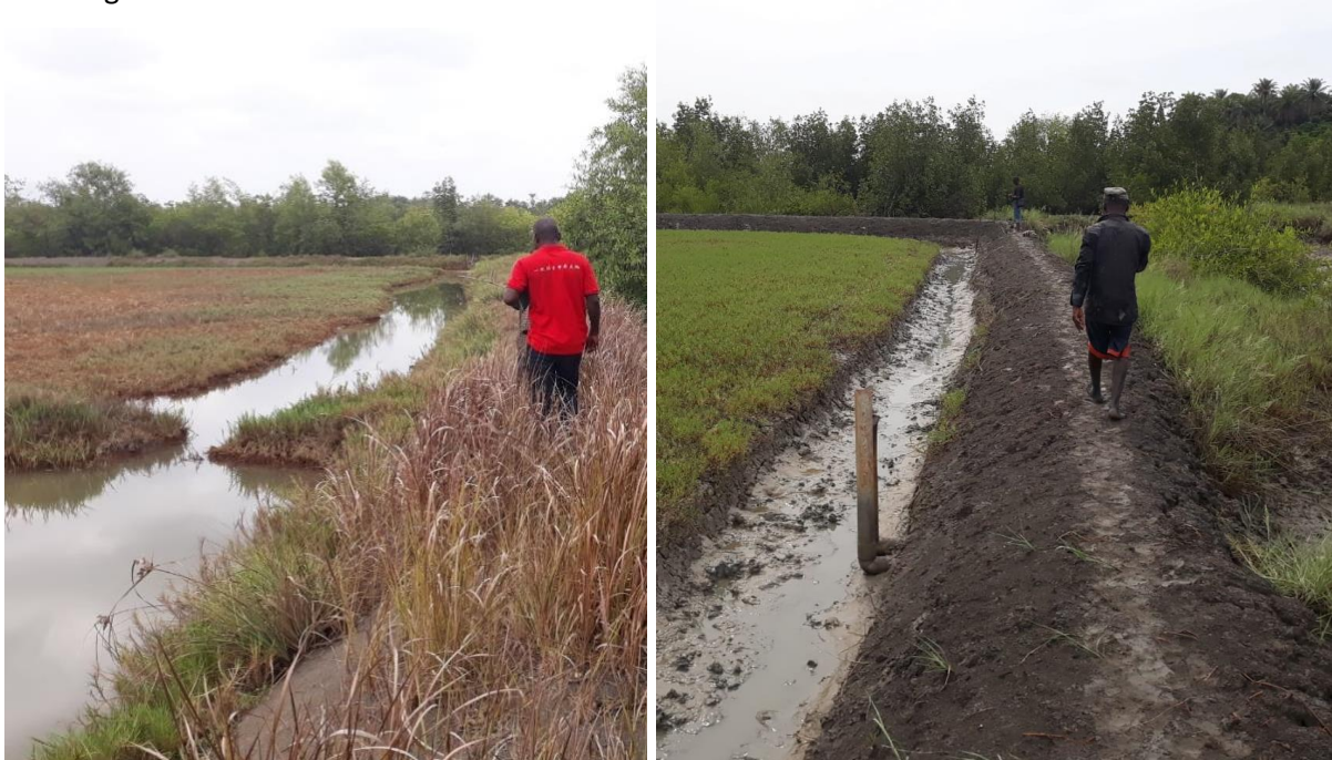
Gauche : Brêchage entre deux casiers à Pogolong
