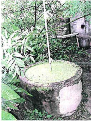
(Cf. Cadre E). Le passage du lisier dans ce type de digesteur donne deux types de produits : liquide, important en quantité, qui contient encore les éléments fertilisants en grande quantité, et solide, une sorte de matière sableuse sèche et facilement transportable et épandable, à vider à une fréquence variable mais de l'ordre de plusieurs années selon le volume du digesteur et le nombre de cochons élevés.
