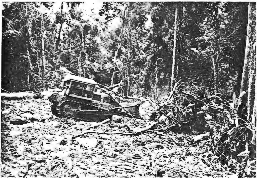
Création du parc de stockage LO P 2 - P 3 par le tracteur à chenilles Caterpillar D8
