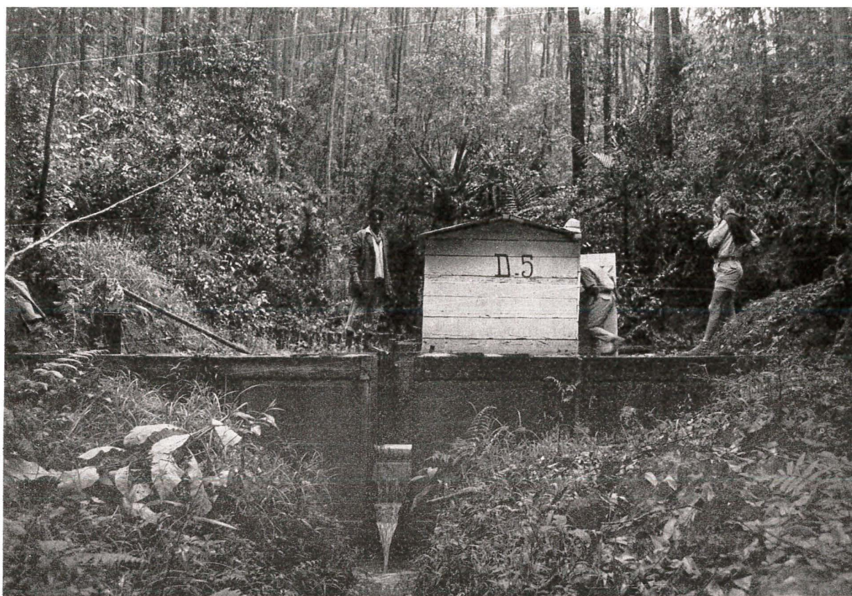
Grand bassin versant de Périnet. Déversoir D5 à Betsakotsako.
