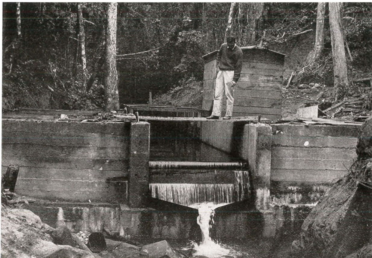
Grands bassins de Périnet. Déversoir D4 à Ampangalatsary.
