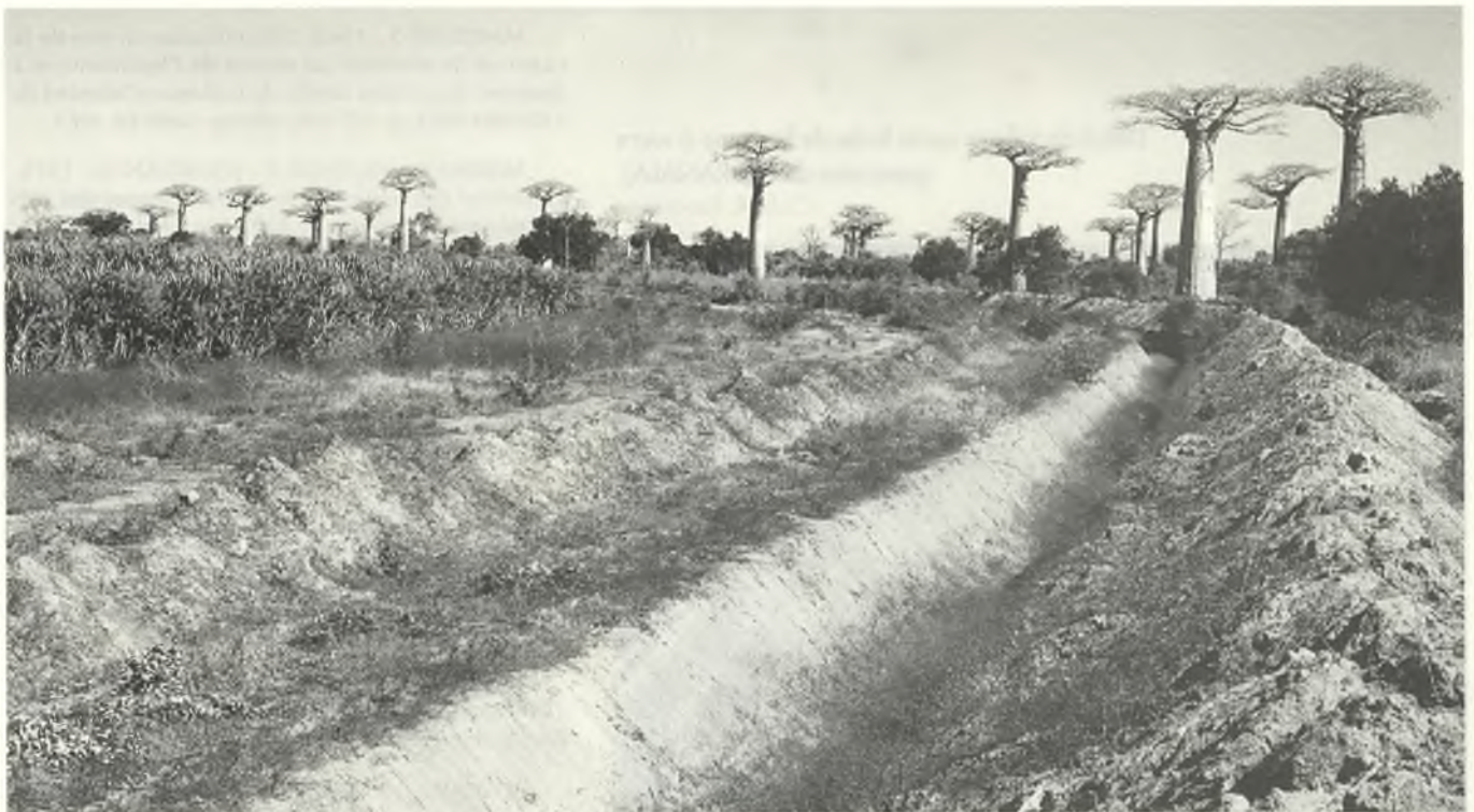
Périmètre de SIRANALA. Drains de ceinture pour éviter l'entrée des bovins.
