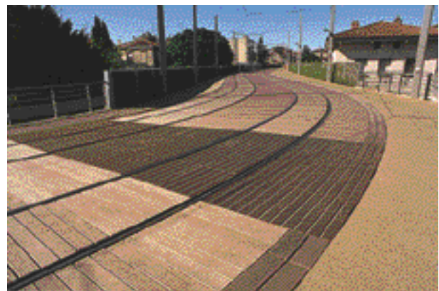
Photo 4. Passage pour piétons avec système antidérapant.
