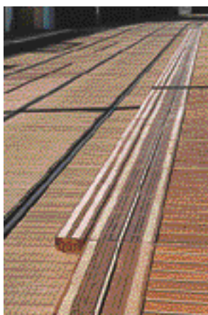
Photo 6. Aménagement des quais et des rampes d'accès.
