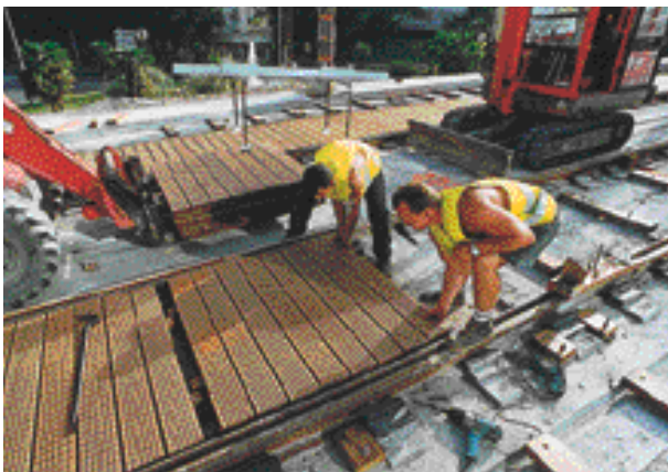
Photo 3. Mise en place du panneau par glissement sous le panneau précédent.
