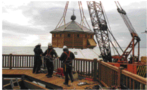
Photo 3. Le phare (pin traité et western red cedar ) va être arriéré sur la base.
