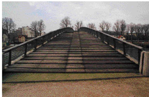
Photo 1. Platelage en ipé. Passerelle piétonne au-dessus du barrage de Saint-Maurice-Maisons-Alfort sur la Marne.
