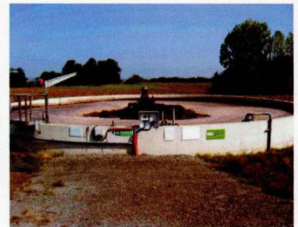
Photo 16. Bassin de nitrification/dénitrification d'une unité de traitement biologique de lisier (J-M. Médoc).
