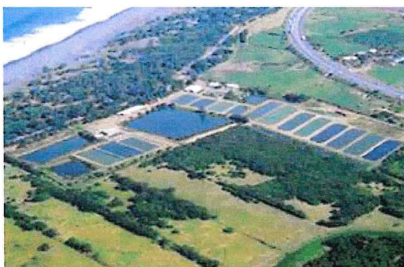
Figure II. Vue aérienne de la station d'aquaculture continentale d'Etang-Salé (source : www.arda.fr ).
