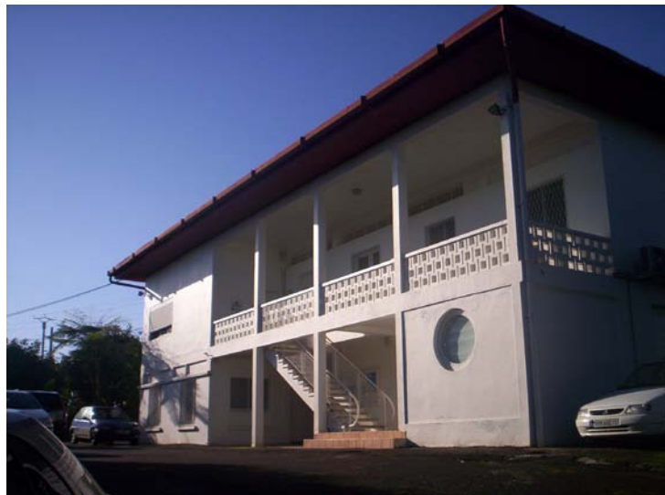
Le bâtiment de la Direction, Neufchâteau
