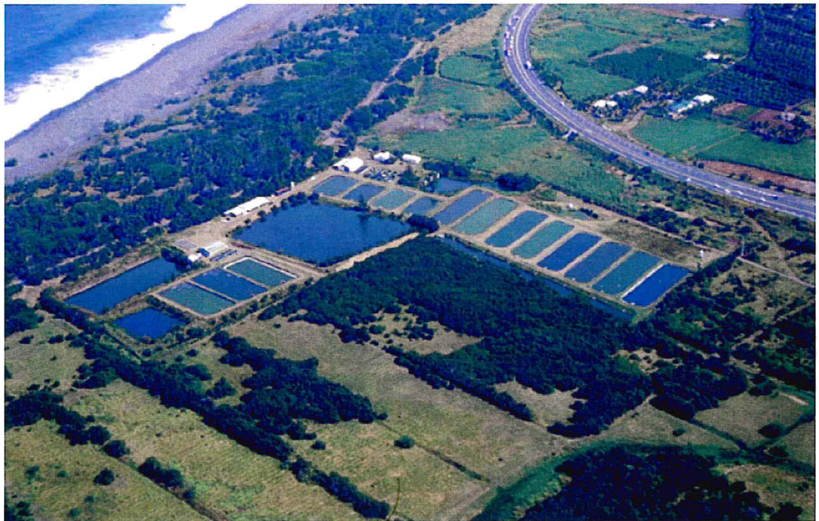
Figure 2 : Station d’Aquaculture Continentale, localisée sur le complexe marais-étang de la Plaine du Gol à l’Etang-Salé (photo ARDA).
