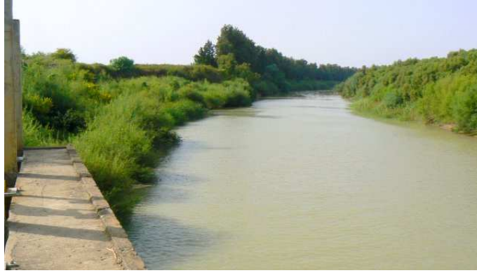
Photo 5 : Oued Sebou vu de la station de pompage du secteur S7B
