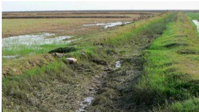
Photo 3 : tranchées en terre ou « arroseurs »
