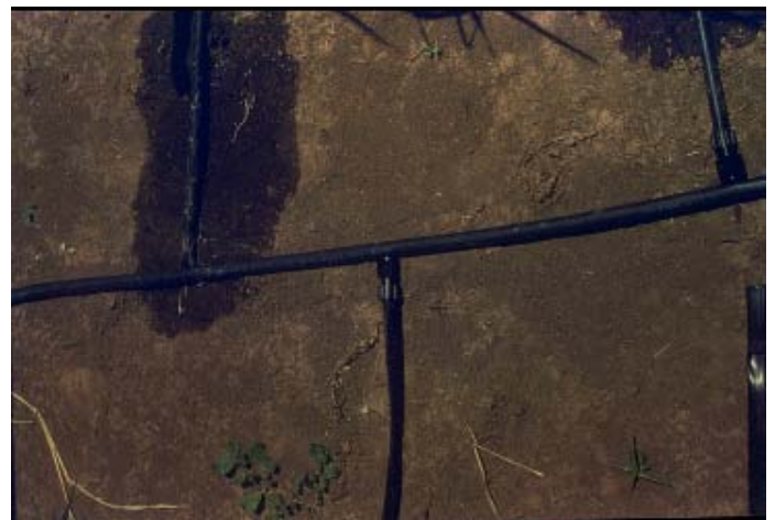
4. Gros plan sur le goutte-à-goutte. Arrêt irrigation possible sur une base parcellaire
