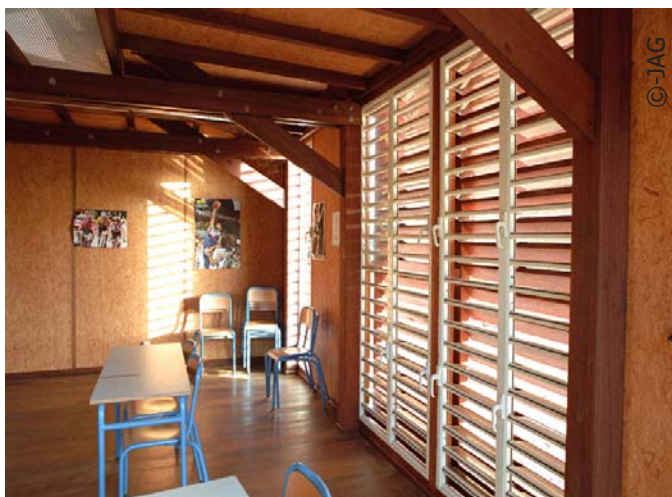
L'intérieur des classes est protégé de la chaleur par les pare-soleil disposés sur les ventelles côté ouest.
