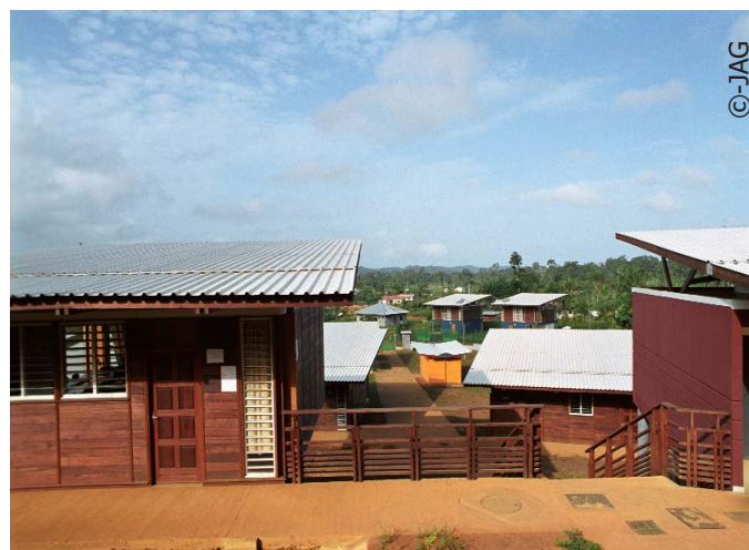
Vue générale du collège.
