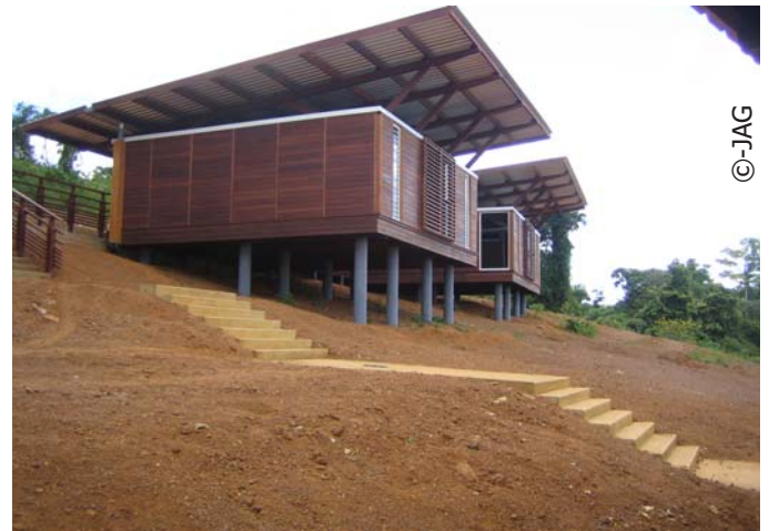
Côté bas, les pilotis permettent de conserver la pente du terrain sans terrassement importants.
