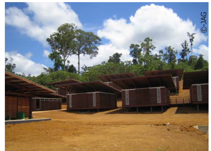
La toiture "décollée" permet une meilleure ventilation de la sous toiture. Les débords de toiture protègent les façades du soleil et de la pluie.
