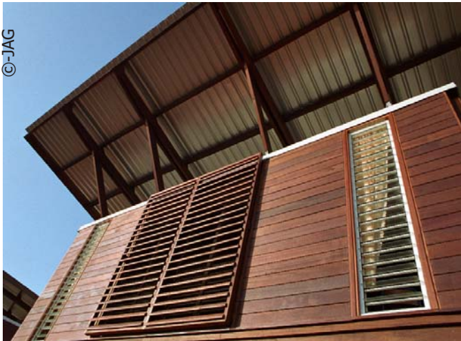
Protection des baies vitrées contre le soleil aux heures chaudes.
