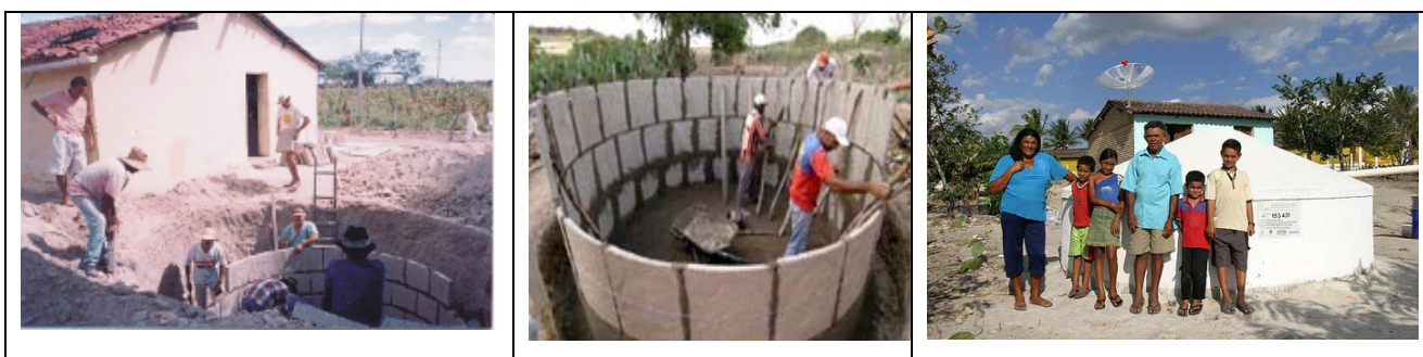
Figura 03 – Imagens de uma cisterna sendo construída pelo Programa PIMC
