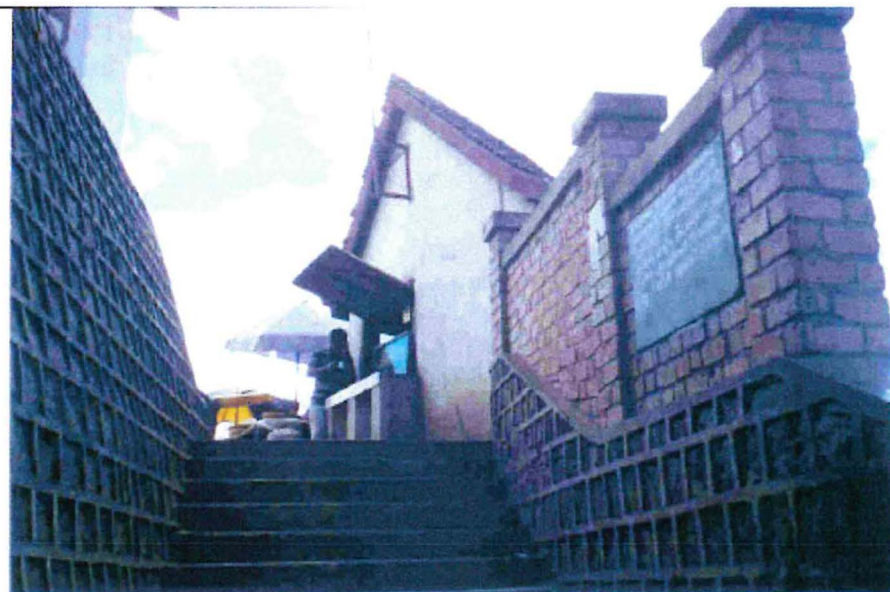
Photo 10: Ardoise sur les murs près du marché à Ambohidratrimo
