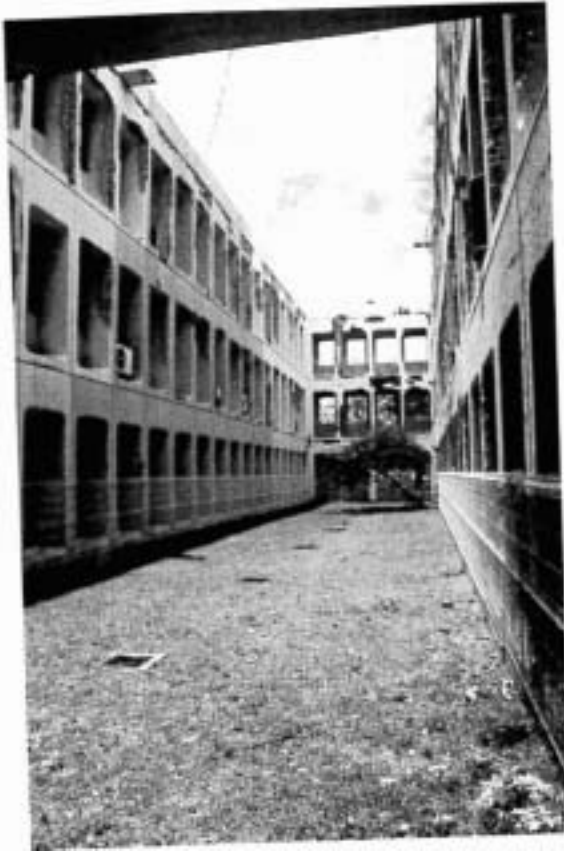
photo! : Les bâtiments de l'UAG
