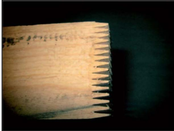
Figure 3.2.1 : Profil des entures multiples
