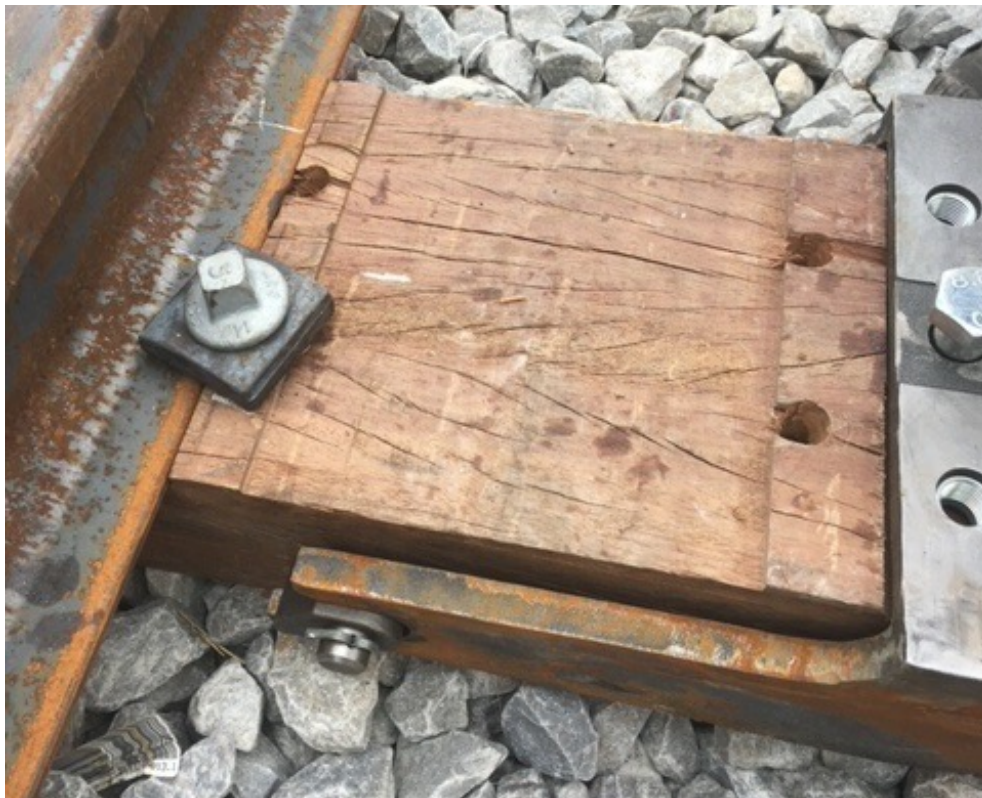
Détail du montage d'un assemblage avec une pièce en Azobé (rail/pneu) pour la ligne de métro n°6 à Paris (photo Rail Europe)
