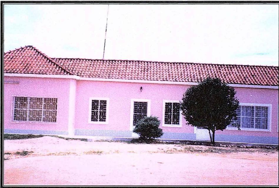
Bureaux du projet 7 ACP – RPR 146 à LUBANGO
