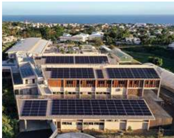
Panneaux photovoltaïques, site de La Réunion © Cirad
