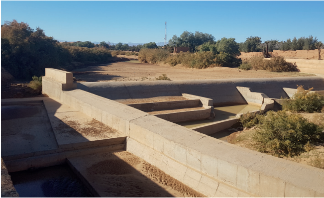
Digue d'épandage des eaux de crues
