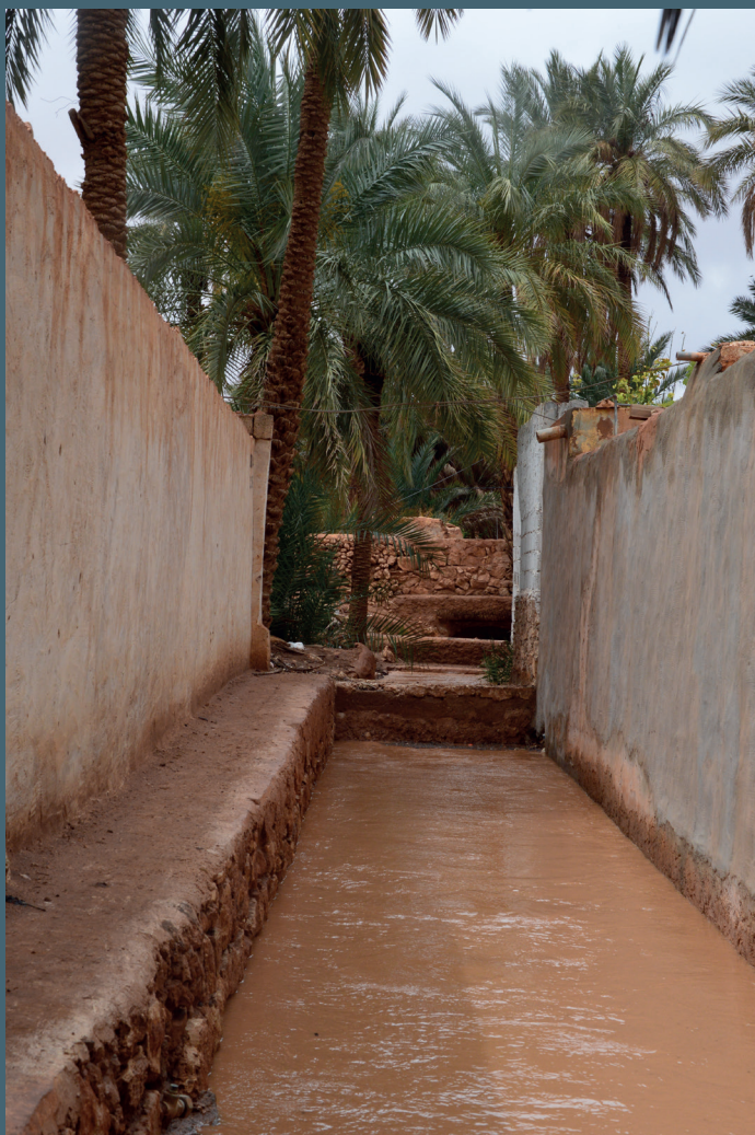
Canal d'amenée au puits d'injection
