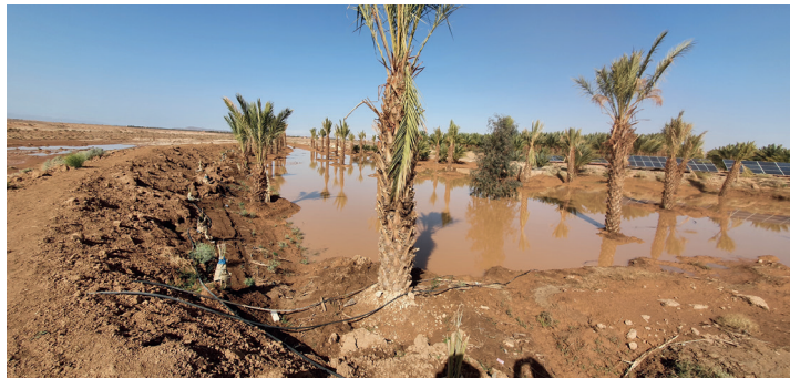
Bassin de collecte des eaux des crues
